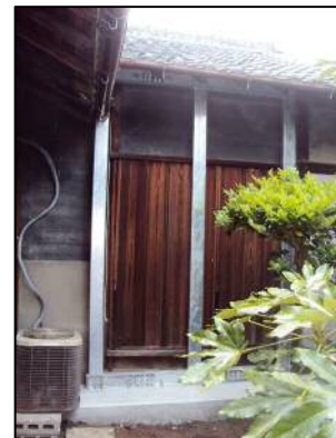
列柱タイプ設置状況
